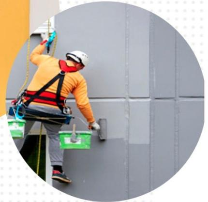
**EVOFLEX FACHADA** é uma tinta acrílica elastomérica (emborrachada) acetinada PREMIUM. Sua aplicação cria uma membrana que repele imediatamente a água, protegendo a superfície contra umidade e ação do tempo. Por ser emborrachada, acompanha a movimentação do substrato evitando microfissuras e promove melhoras significativas no conforto térmico, comprovada por laudos.
